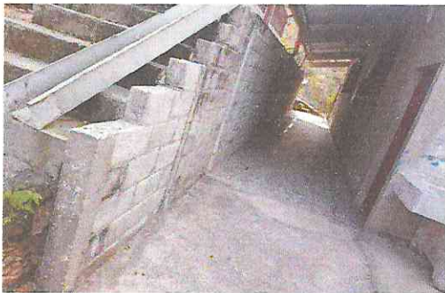
Foto 3: Área de muro de contención para repellar
