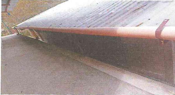
Foto 1: Área de canal y bajas de agua pluvial.
